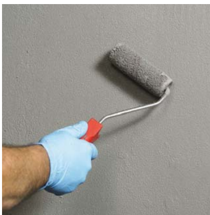
Wykonać 1. warstwę (malowaną) na pozostałej powierzchni podłoża.
