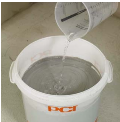
Dodać wody (10% w stosunku do ilości składnika płynnego), wymieszać dla uzyskania konsystencji zaprawy do malowania i natrysku.
