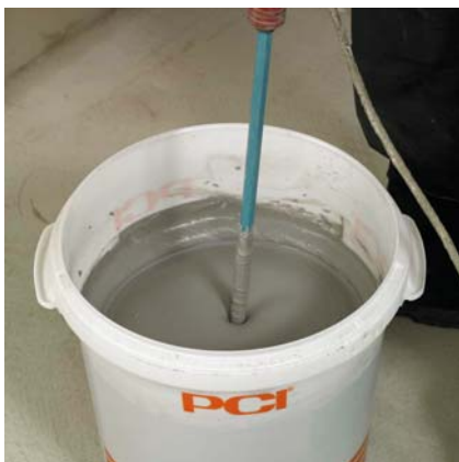
Wymieszać oba składniki dla uzyskania konsystencji zaprawy do szpachlowania.
