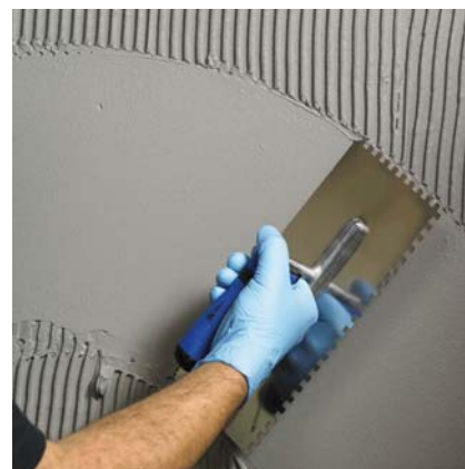
Położyć na całej powierzchni 2. warstwę (szpachlowaną) dla uzyskania łącznej wymaganej grubości uszczelnienia.
