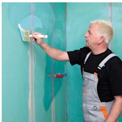
Gruntowanie nierozcieńczonym środkiem PCI Gisogrund®.
