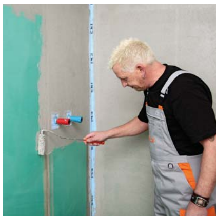
Nałożenie (z pełnym pokryciem podłoża) warstwy izolacji PCI Lastogum® szary na pozostałej powierzchni z jednoczesnym przespachlowaniem brzegów taśm i manszet.
